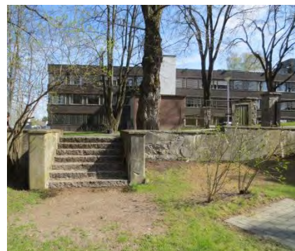
Figur 89 Inngangsport og trapp til tysk brakkeleir
