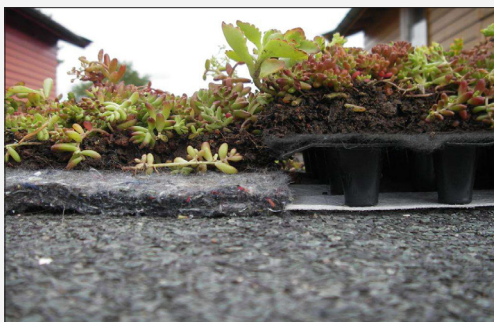
For sedumtak er ikke selve dekke tjukt og tungt. Som vist på bilde er jordlaget ikke tykkere enn 3cm.
