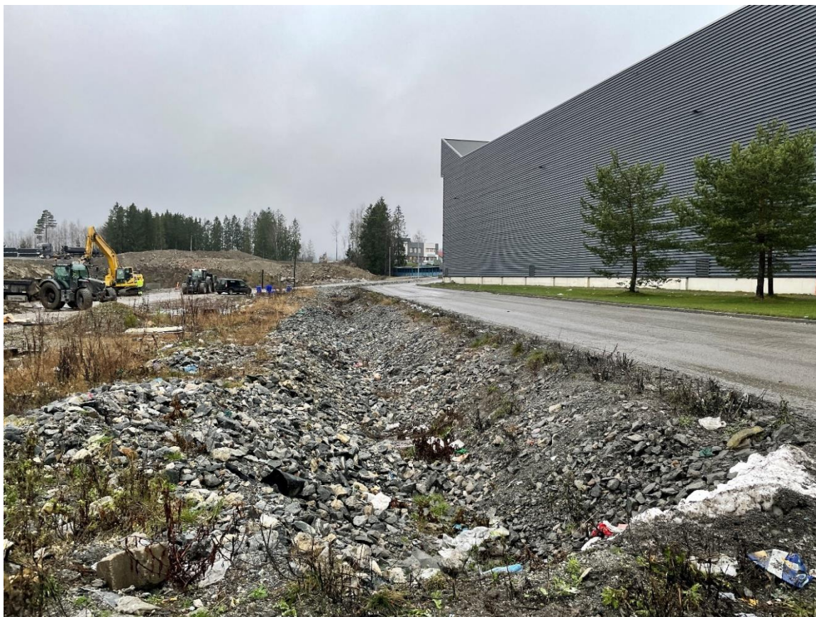
Figur 8 Eksisterende åpen grøft (Kilde: bildet tatt på befaring).
