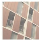
gjenbrukt/gjenbrukbar lett metallkledning (tre elementer/fasademoduler)
