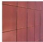
BIPV fasadeintegreerte solceller (rødt)
