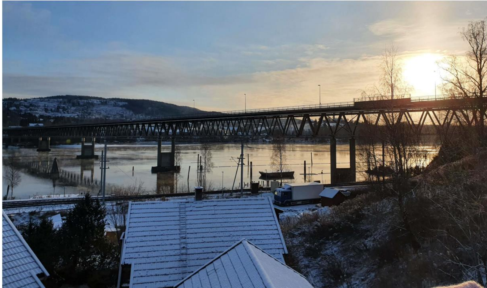
Dagens bru: Fagverksbru i stål med overliggende betongdekke (sidespennene som platebru i betong)
