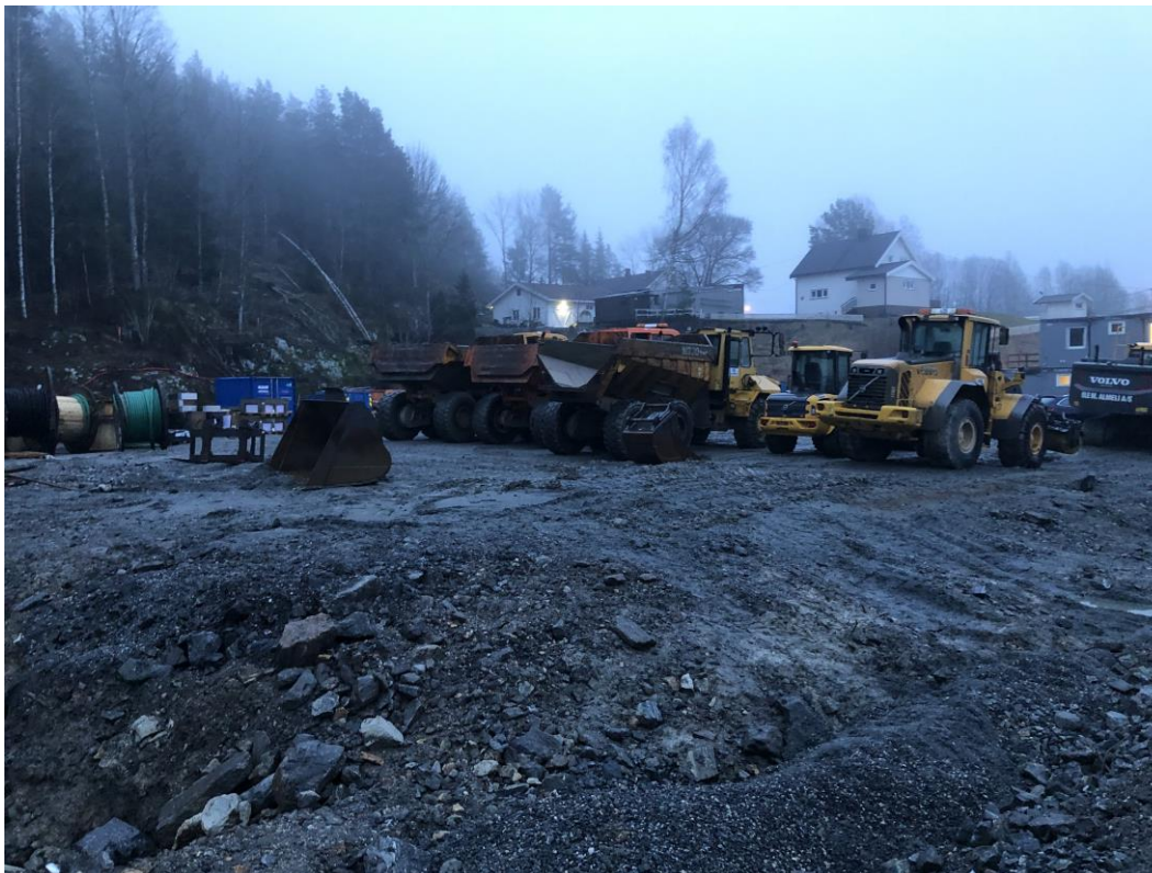
Bilde 3.5 Bilde fra befaring i 2020; Fyllarbeider, ferdig planert.
