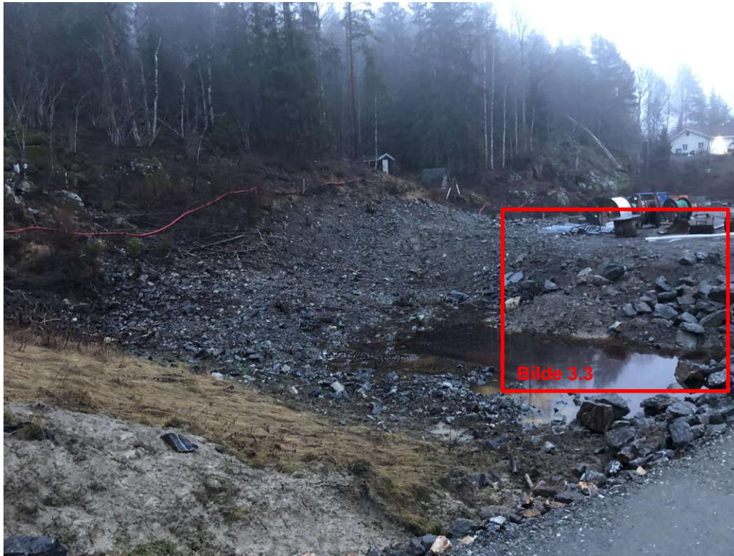
Bilde 3.2 Bilde fra befaring i 2020; Fyllingsarbeider pågår
