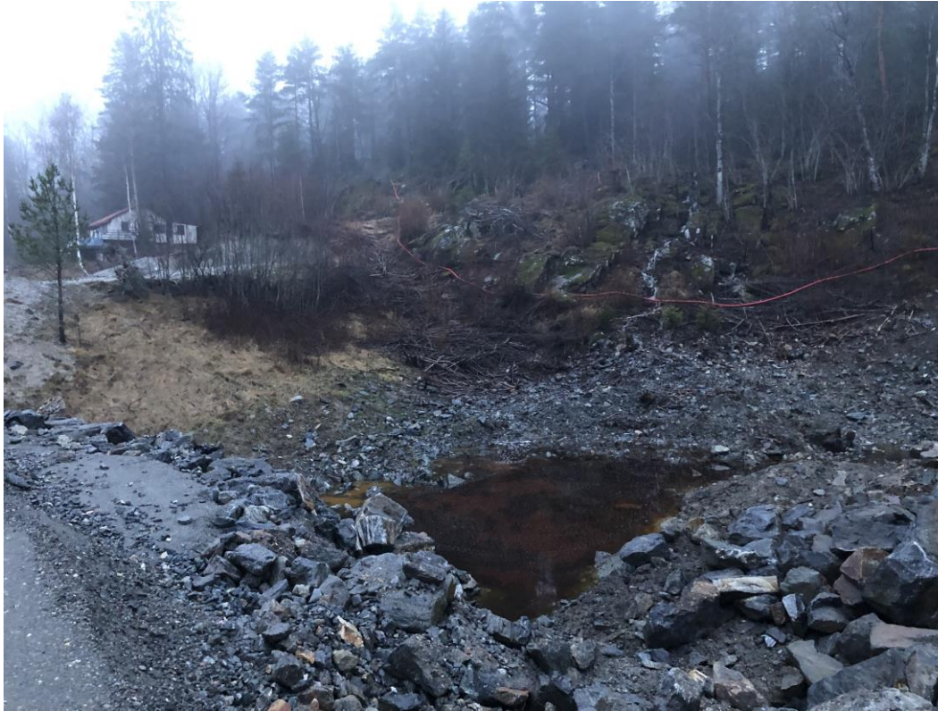
Bilde 3.4 Bilde fra befaring i 2020; Fyllarbeider, ikke ferdig.
