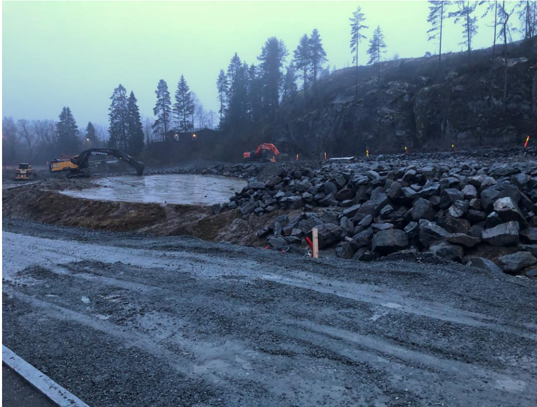
Bilde 3.6 Bilde fra befaring i 2020; Fyllarbeider i området, grove masser/sprengstein.
