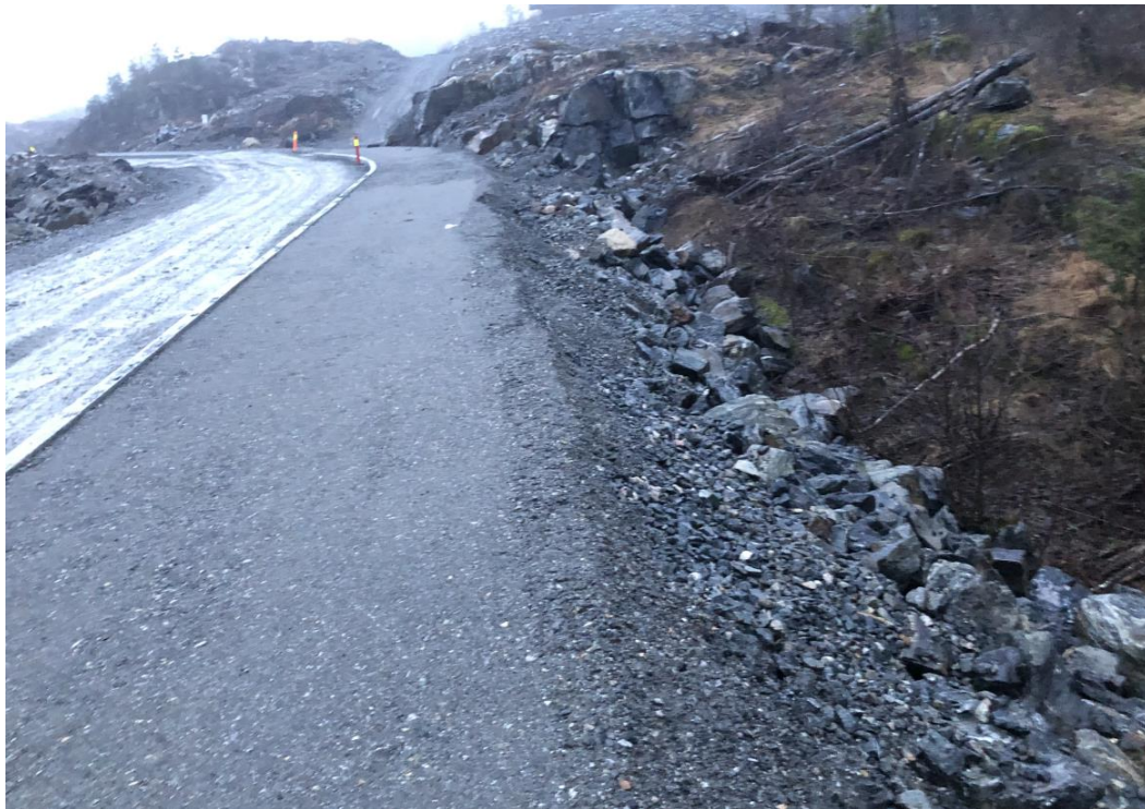
Bilde 5.1 Bilde fra befaring i 2020; Varige masser i fyllingsarbeider, viktig med filterkriter.
