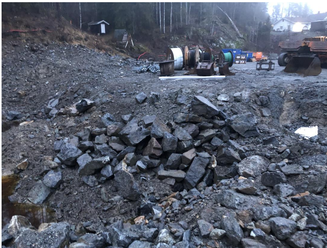
Bilde 3.3 Bilde fra befaring i 2020; Fyllarbeider grovt spengstein.
