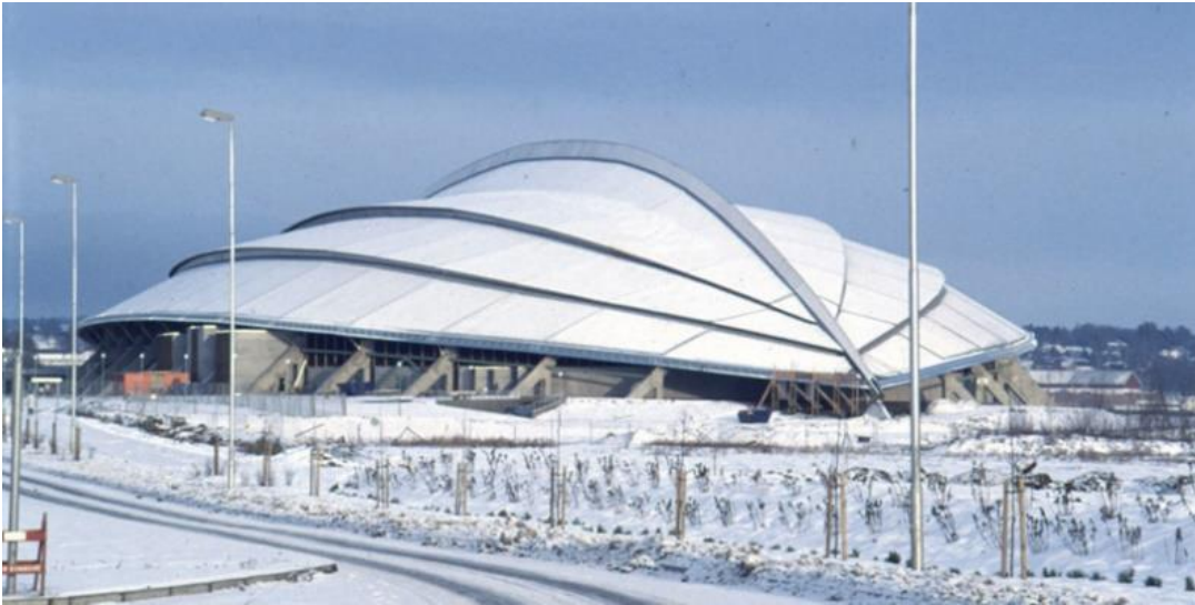
Figur 4-24 Nasjonal anlegg, Vikingskipet i Hamar. Foto: bygg.no
