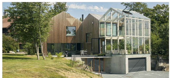
Figur 4-18 Enebolig Hellerudveien, Oslo. Fotograf: Herman Dreyer
