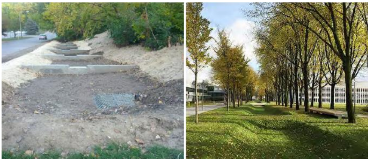
Figur 14: Eksempler på terskler av betong (til venstre) og jordmasser (til høyre)
