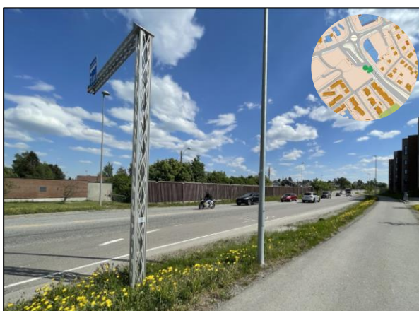
Figur 8 - Bilde av forsenkningen i Skedsmo kirkevei og punktet der forsenkningen renner over ved enden av støymuren.
