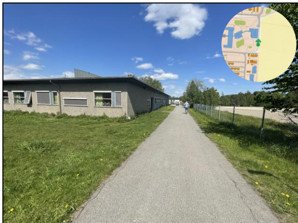
Figur 19 - Bilde av området hvor flomveien passerer Åsenhagen skole og renner ut på Fribergjordet. Gangveien i mellom som utgjør det nordligste punktet i områdereguleringen.
