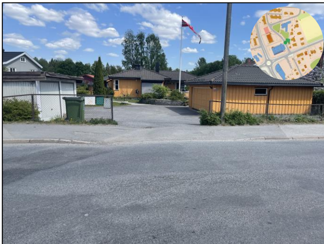
Figur 15 - Bilde av det punktet hvor flomveien renner inn mot Korshagen 4.
