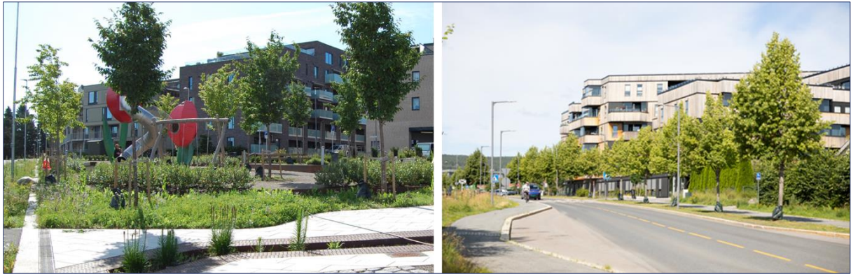
Figur 29 Bildet til venstre viser fasade nord og vest på Linjekvartalet 1, med Slettparken i forgrunnen. Bildet til høyre viser Linjekvartalet 2, sett fra Blakerveien/Noractorgården.
