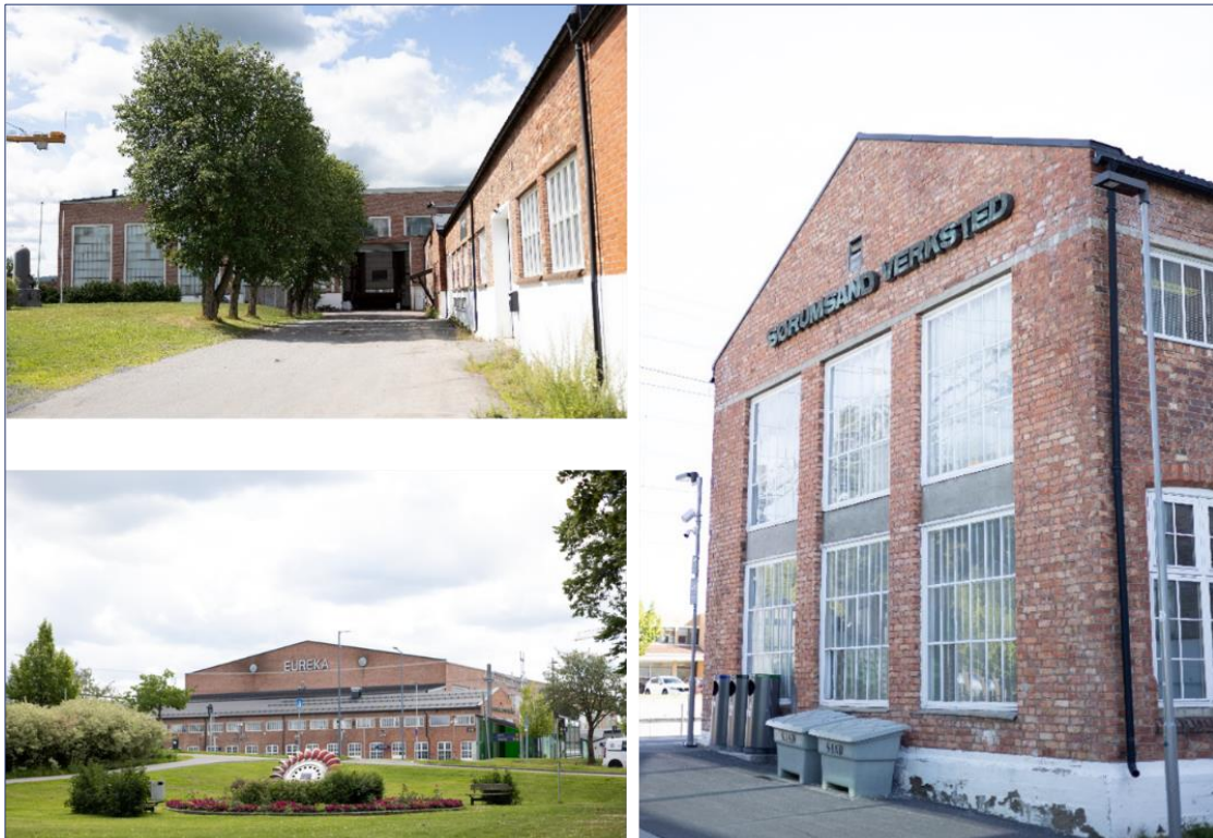
Figur 18 Sørumsand verksted med Verkstedhallen «Eurekabygget» er godt synlig i det bebygde landskapet i Sørumsand sentrum. Bildet øverst til venstre er tatt fra indre gårdsrom. Bildet nede til venstre er tatt fra Rådhusparken, og viser fasade nord, mot sentrum. Bildet til høyre er tatt fra stasjonsområdet på sørsiden av Kongsvingerbanen.
