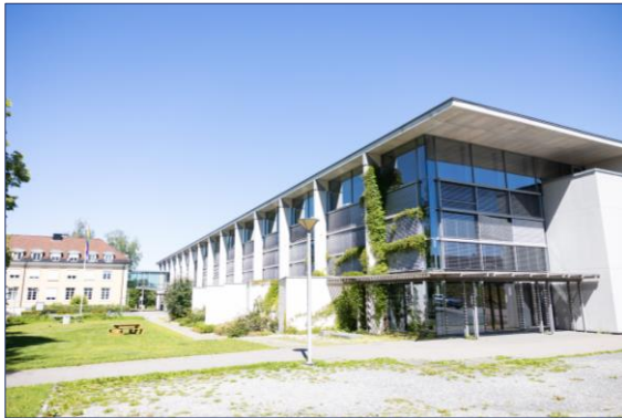
Figur 22 Utvidelse av Sørumsand vgs., ferdigstilt i 2002. Bygget er oppført i tre etasjer, hovedsakelig med flatt tak.
